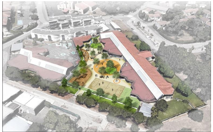
MOE mandataire pour la cour oasis de l'école élémentaire LESSEPS à Toulouse : un exemple qui illustre les projets de désimperméabilisation et de végétalisation en ville, chers à Terreauciel, mais aussi de mixité d'usages.
